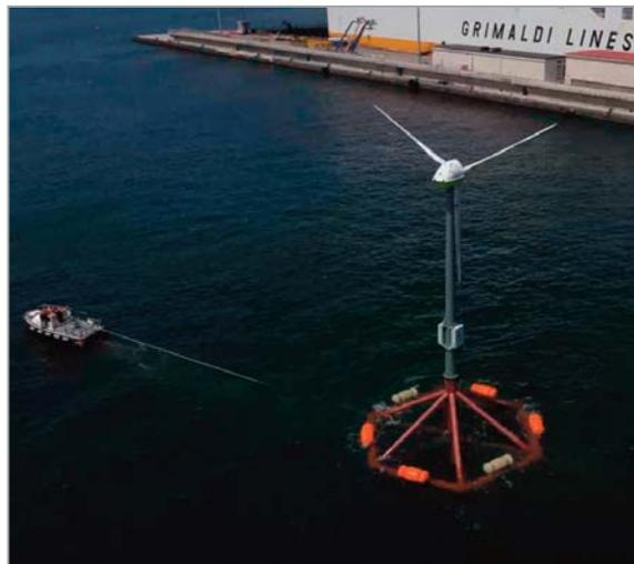
La turbina eolica con la piattaforma Hexafloat
