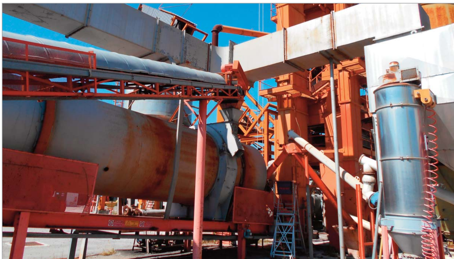
Impianto di recupero inerti
