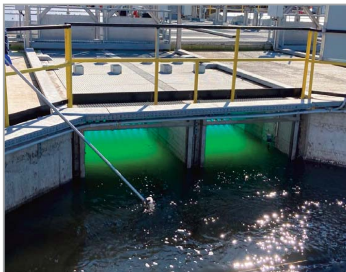
Foto 2 - Prelievo campione acque di scarico presso impianto di depurazione (fonte: Dipartimento ARPAC Caserta)
