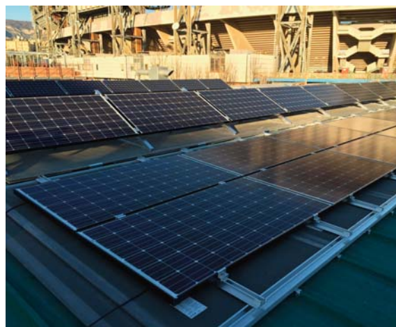
Impianto fotovoltaico da 7 kW di picco basato su tecnologia HIT installato presso il CNR Istituto Motori
