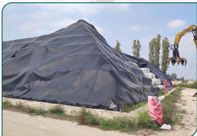
Fig. 3 • Copertura con teli in HDPE delle ecoballe
