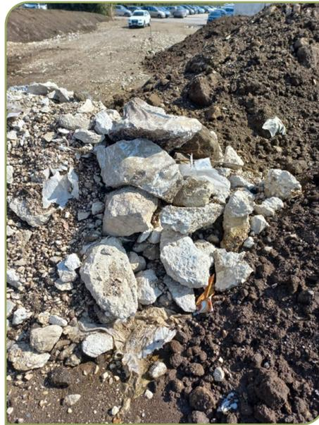
Foto 3: Lavori di riempimento mediante utilizzo illecito di rifiuti da demolizione
