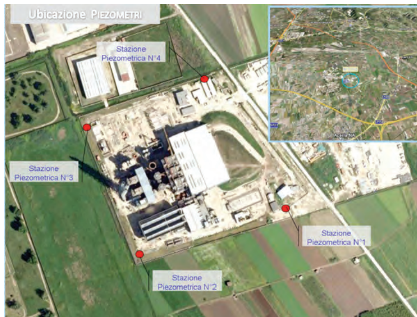
Foto 1 - Ubicazione dei pozzi spia (Fonte Osservatorio Ambientale)
